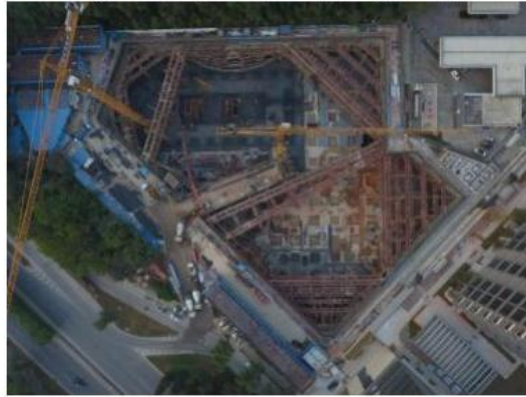
图 3 美景工业苑基坑工程全景图
